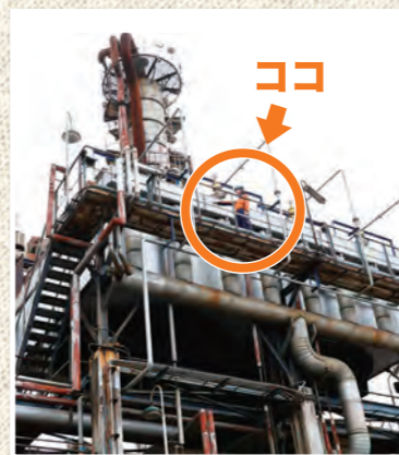
高所での作業も珍しくない。4階建てのビルくらいの高さでパトロールしている様子。一番高い場所だと地上60mにもなる!!
